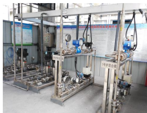
選擇性非催化還原法脫硝系統安裝情況
