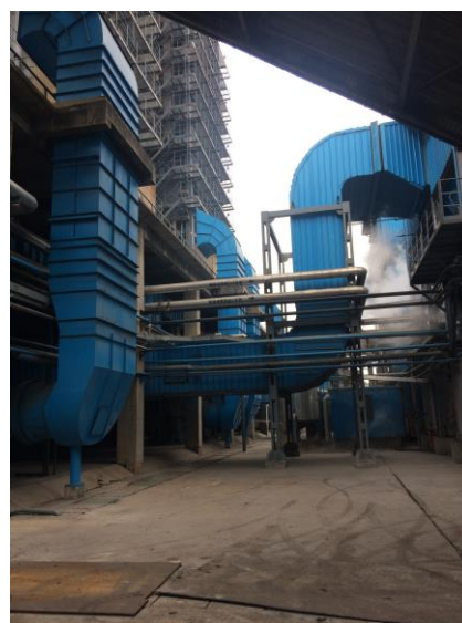
選擇性非催化還原法脫硝系統管道外觀
